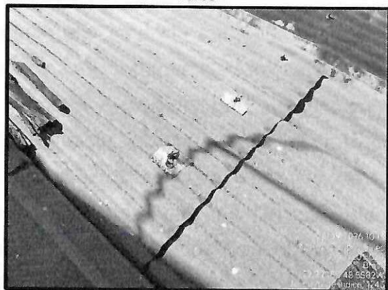
Figura 6 – Cobertura em arco com ganchos vedados com manta asfáltica e telhas com pontas levantadas
