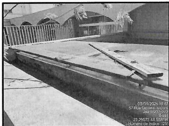
Figura 7 – Laje Impermeabilizada + Claraboia
