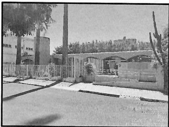
Figura 1 – Fachada da Edificação
